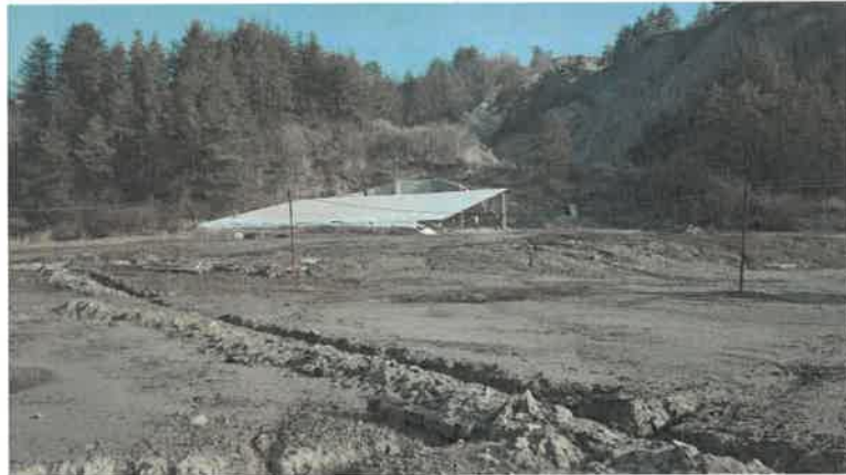
Platforma minelor vechi cu acoperișul puțului minei Iosif
