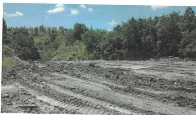
Zona sudică a hălzii faza: nivelare-acoperire (2019. 07.05.)
