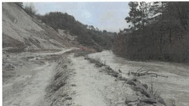
Digul de protecție al platformei minelor vechi, pe malul drept al pâraului Corund în timpul unei viituri din data de 14.03.2018.
