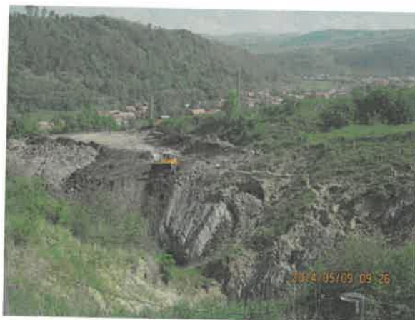
umplere și nivelare (2014.05.09.)
